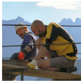
Ölen des Zugseils der Seilbahn
