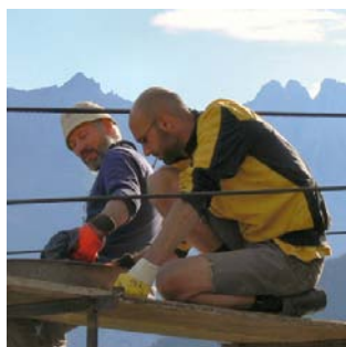
Si mette l'olio sulla fune traente della teleferica
