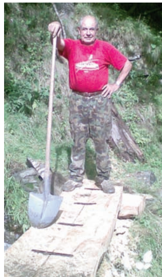
Neue Brücke bei Graslic
