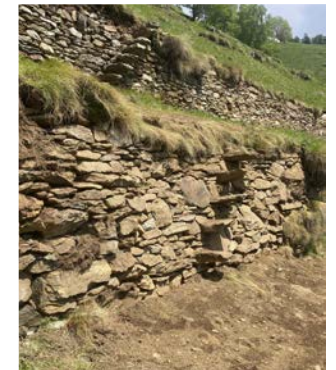
Neu aufgebaute Trockenmauer in Stenc
