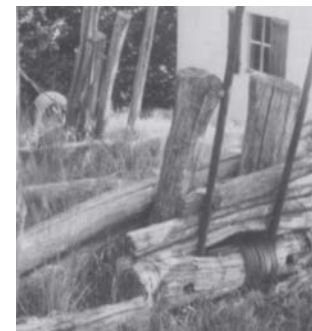
Die Battüda (Verankerung am unteren Ende des Seils mit Vorrichtung zum Spannen)
