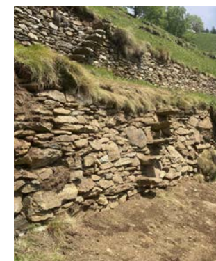
Muro a secco ricostruito a Stenc
