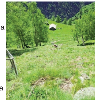
lavori in pendio
